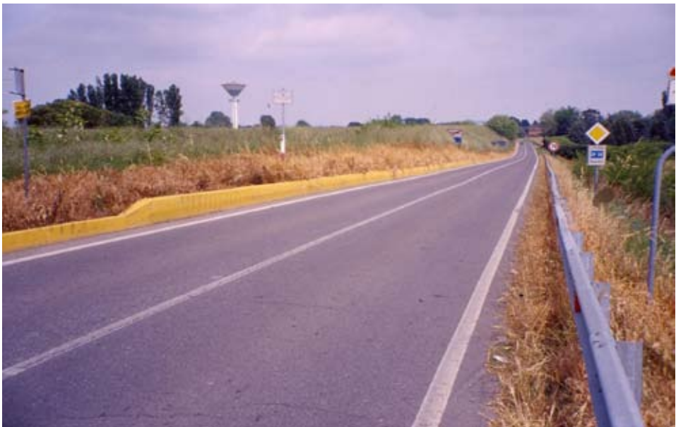
Fig. 2 – Esempio di intervento di diserbo chimico da parte di Ente pubblico (Provincia di Ravenna) in frazione Masiera di Bagnacavallo, inizio di via Rossetta presso il ponte sul fiume Senio (Foto E. Contarini, 2014).
