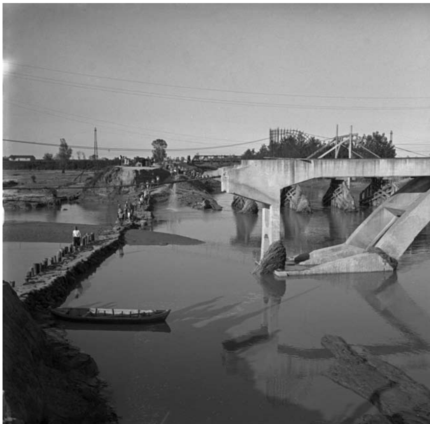
Fig. 3 – ARCHIVIO FOTOGRAFICO DI PIETRO ZANGHERI, Santa Sofia, Parco Nazionale delle Foreste Casentinesi, Monte Falterona, Campigna. Savio (bassa pianura ravennate): effetti della piena del fiume, con un ponte crollato e lavori di ripristino in corso. Immagine datata 4 giugno 1939 (negativo n. 1094).
